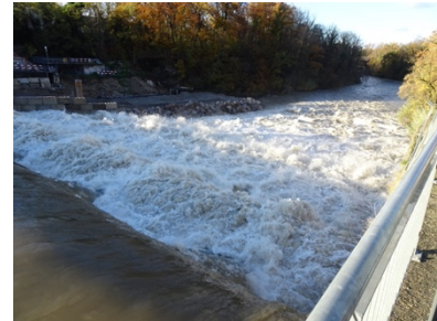
Wasserschwelle beim Kleinwerk in Münchenstein
