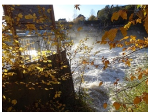
Wasserschwelle Richtung St. Jakob
