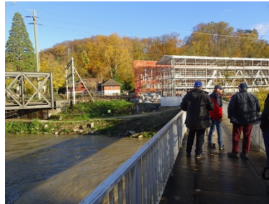
Links alte Eisenbahnbrücke in Münchenstein/ rechts die neue im Bau
